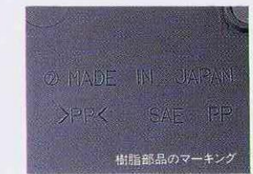
MADE IN JAPAN PPK SAE IPP 樹脂部品のマーキング
